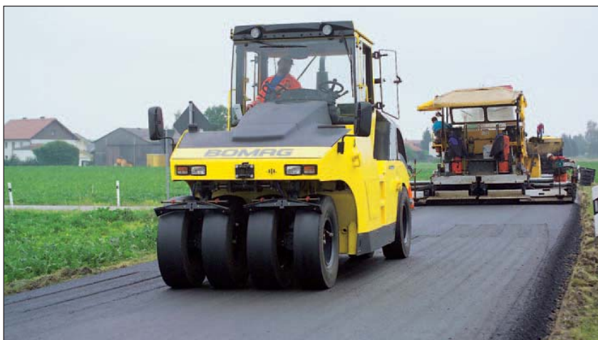
Los BW 24 RH y BW 27 RH son compactadores de neumáticos flexibles para todos los trabajos típicos en el movimiento de tierras y en asfalto.
